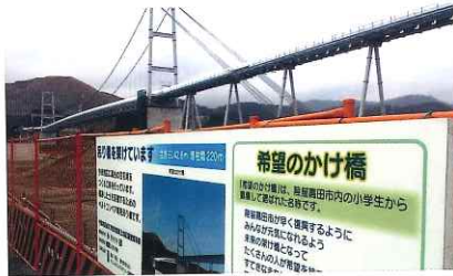
嵩上げ工事用ベルトコンベアの橋(岩手県陸前高田市)
