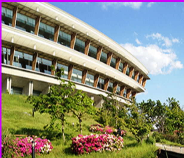
＜葉山本部の建物外観＞
