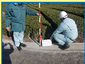
国調図根点金属標埋設の様子
